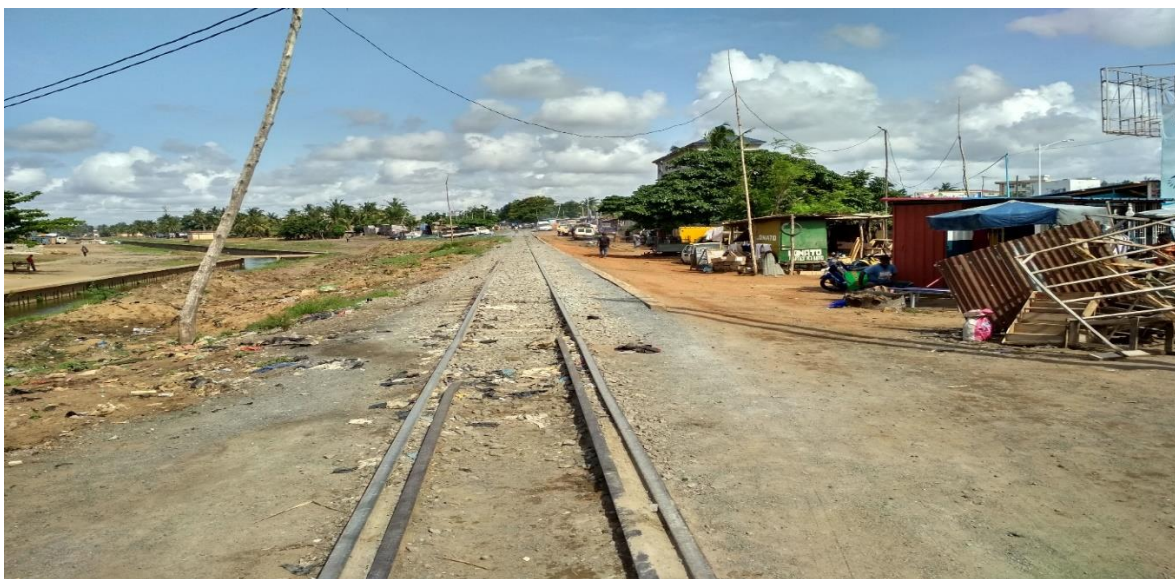
Photo 13 : Emprise ferroviaire occupée par les riverains
