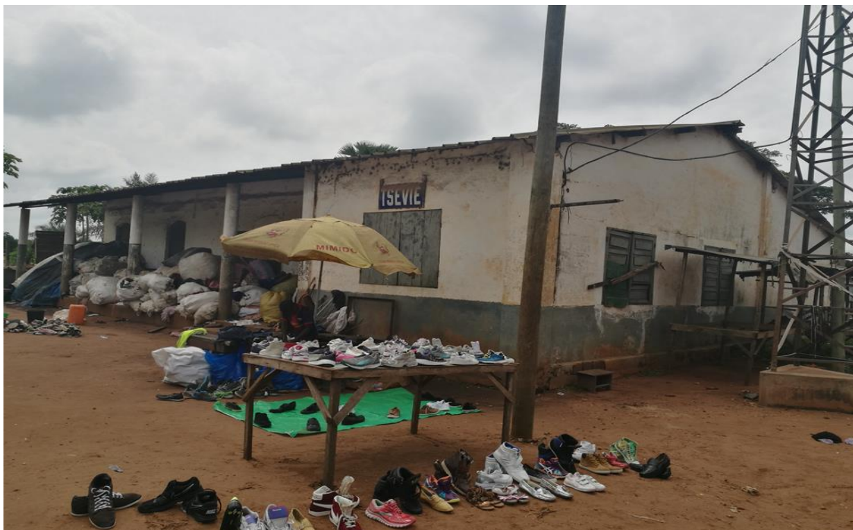
Photo 17: Le principal bâtiment de la station de Tsévié devenu magasin de friperies.
