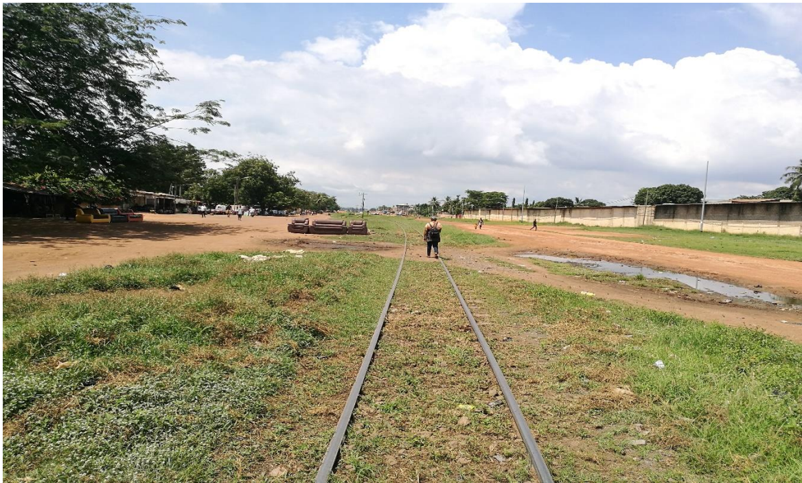
Photo 12: Emprise ferroviaire normale de 50 m de chaque côté de la voie
