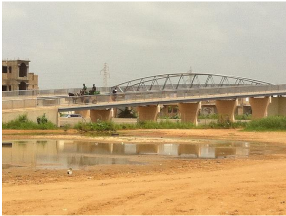
Photo 3 : Utilisation d'une charrette par un résident de la cité Djaraff, pour se rendre au garage spontané des « clandos » à Darou Rakhmane (Rufisque Nord). Stratégie d'adaptation pour se soustraire aux contraintes spatiales induites par l'ouvrage autoroutier et à la desserte inégale de leur lieu de résidence
